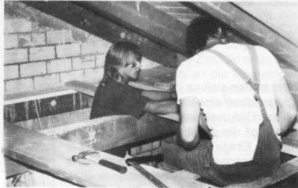
Jugendtreff-Jugendliche beginnen unter Anleitung von Rainer Kaminski mit dem Verlegen des Dielenbodens.
